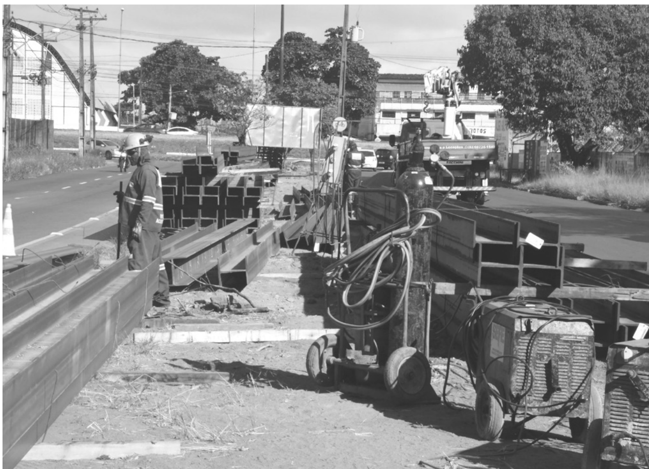
Trabalhadores iniciaram a fundação das estacas metálicas, cada uma com, aproximadamente, 25 metros de profundidade
